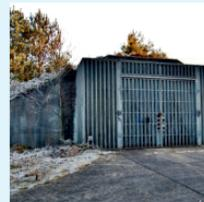
Die Bunker selbst waren mit dem "**Weapon Access Delay System**" (WADS) gesichert. Die massiven Stahlgitterkäfige waren Bestandteil dieses Systems und zur Abwehr von auf den Eingang abgefeuerten Raketenwaffen gedacht. Die dahinter liegenden Türen des Bunkers konnten nur mit speziellen Hilfs-
