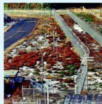
Aufgrund von Terroranschlägen der RAF in ganz Deutschland wurden die **Sonderwaffendepots festungsähnlich ausgebaut, mit mehrfacher Umzäunung, Kampfständen, verschiedenartigen Sensoren** deren Signale in einer Zentrale überwacht wurden. Der bewuchsfreie Innenbereich bot darüber hinaus freies Schussfeld.
