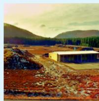
Das **Wartungsgebäude** beinhaltete 3 Wartungsbuchten, Kalibrierraum, Sandstrahlerei, Lackiererei, Lager- und Werkzeugräume. Hier wurden die alterungsgefährdeten Komponenten der Waffensysteme regelmäßig überprüft und gegebenenfalls ausgetauscht. Die Halle war separat mit Tür- und Raumsensoren gesichert.
