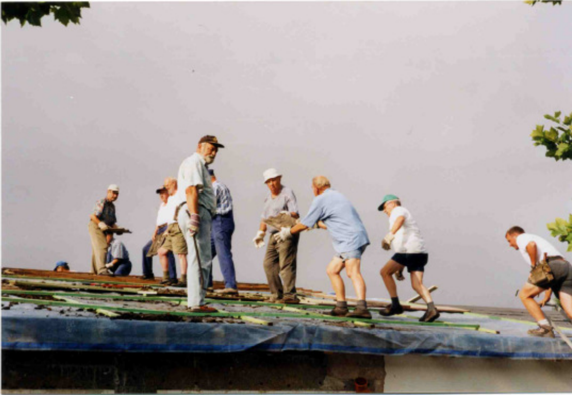
Renovierung und Erweiterung der Leichenhalle
